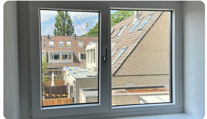
Draai-kiepraam van binnenuit: naar binnen draaiend, met twee ventilatiestanden.
