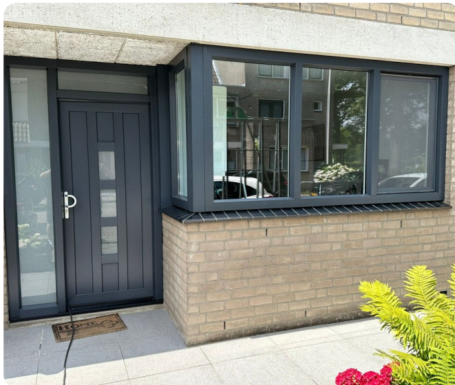
Uitgevoerd werk: kozijnen en voordeur in antraciet, geplaatst door onze eigen monteurs.
