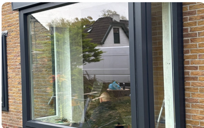
Montage in eigen beheer — geen onderaannemers.
