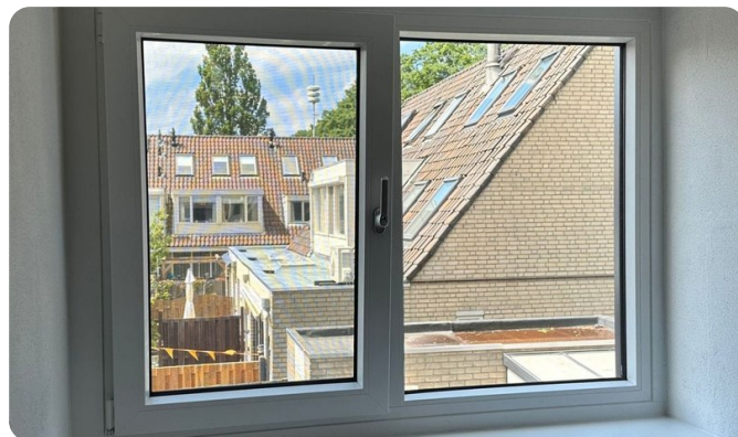
Draai-kiepraam van binnenuit: naar binnen draaiend, met twee ventilatiestanden.
