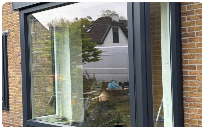
Montage in eigen beheer — geen onderaannemers.
